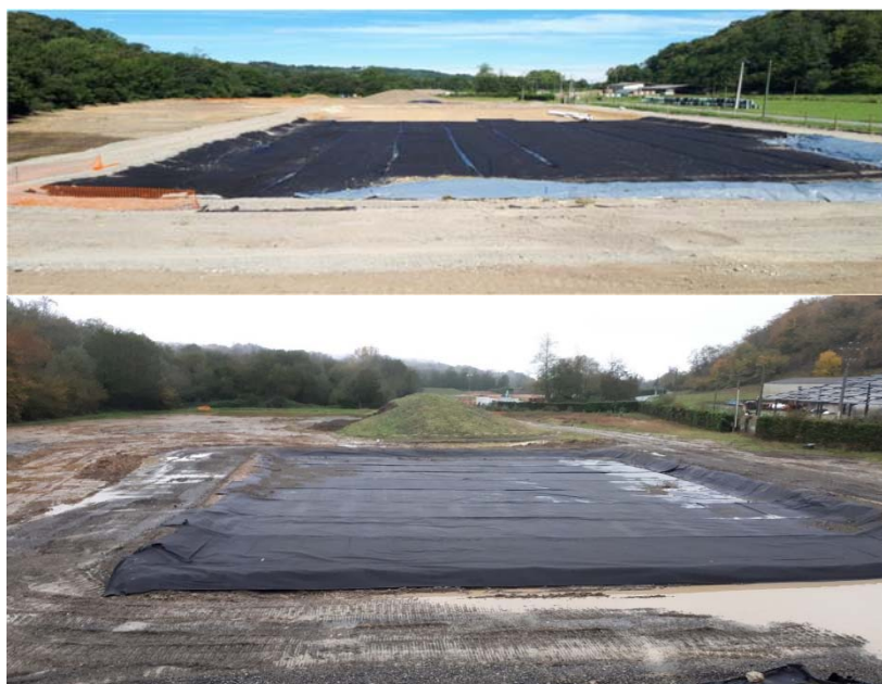
Figure 6 : Mise en place de l'alvéole de stockage des terres polluées
